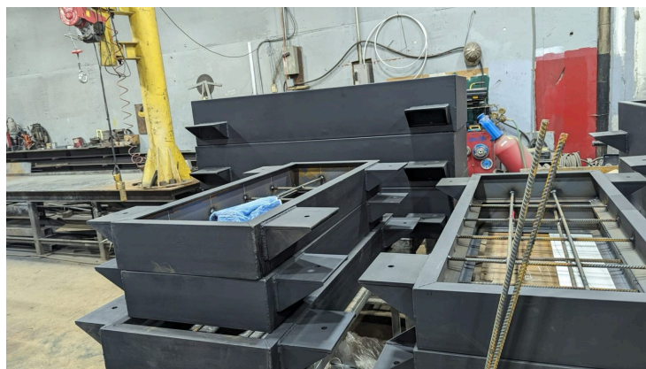
Cadres d'acier en atelier et bases installées sur leurs isolateurs.
